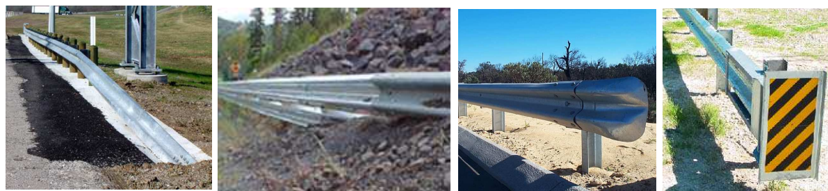
Figura 4.2: Terminali: immerso, immerso su scarpa, a manina, con attenuatore
